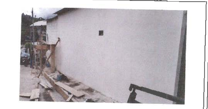
cernido, repello, allsado y pintura del exterior con identificación de la escuela y logo, mantenimiento de la puerta principal.
